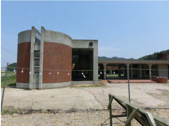
石巻市立大川小学校の校舎
